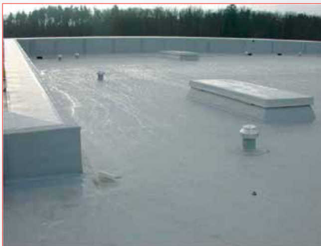
Vakuumentiler i rand- och hörnzon
